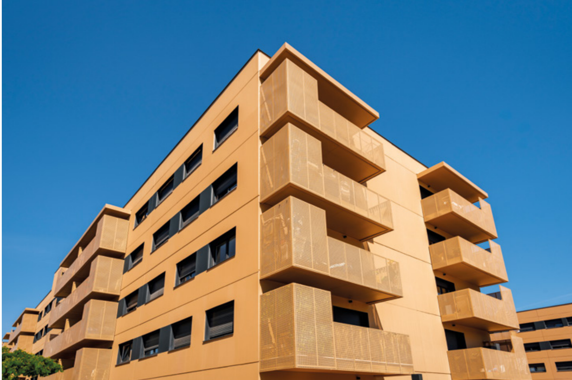
Fotografía del edificio industrializado de Alcorcón, parte del Plan VIVE MADRID
