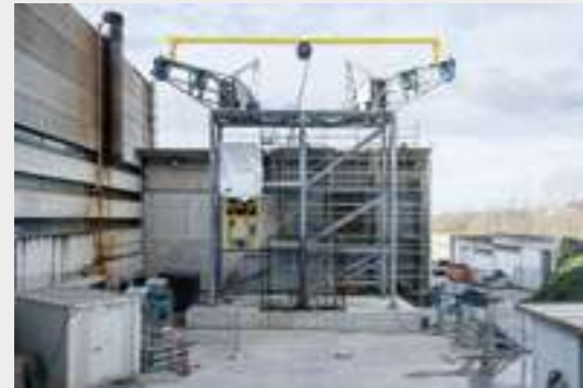
01 Estructura de simulación y robot en las instalaciones de Tecnalia para los primeros tests de funcionamiento.
