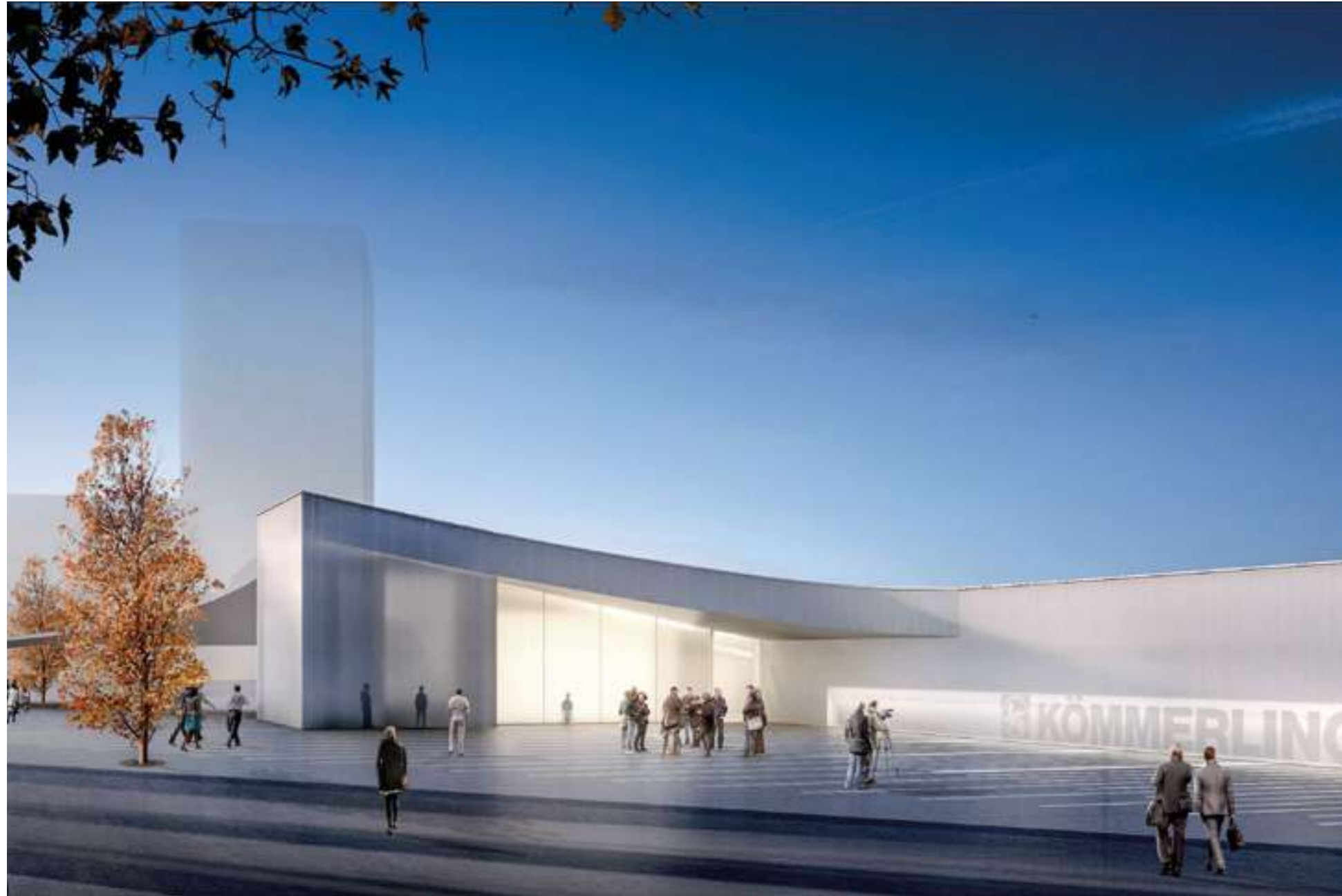
Edificio Zero. Kömmerling
