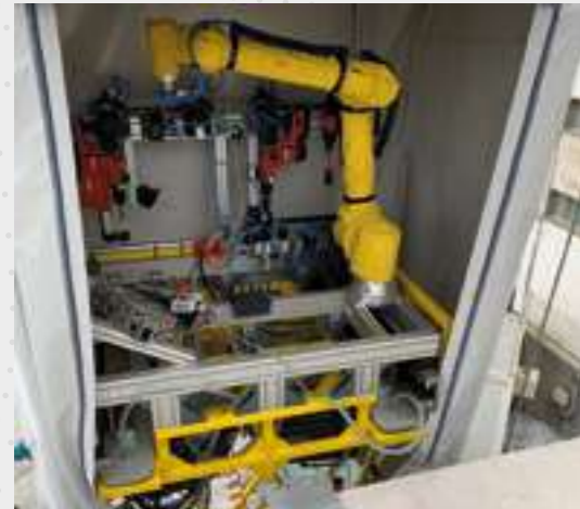
04 Detalle del sistema (end-effector) que instala los anclajes de los muros cortina.
